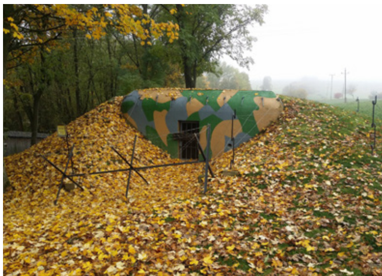
Obnova kamufláže – barevného maskování vojenských bunkerů a pevností vychází z dochovaných původních částí a přizpůsobení okolním přírodním podmínkám, jako třeba u objektů Pevnostního muzea Vranov ve Vranově nad Dyjí.
