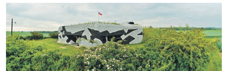
Pěchotní srub MJ-S 4 „Zatáčka“ u Chvalovic je zrekonstruován do stavu ze 60. let 20. století a během sezóny se ve vybraných dnech otevírá pro veřejnost.
