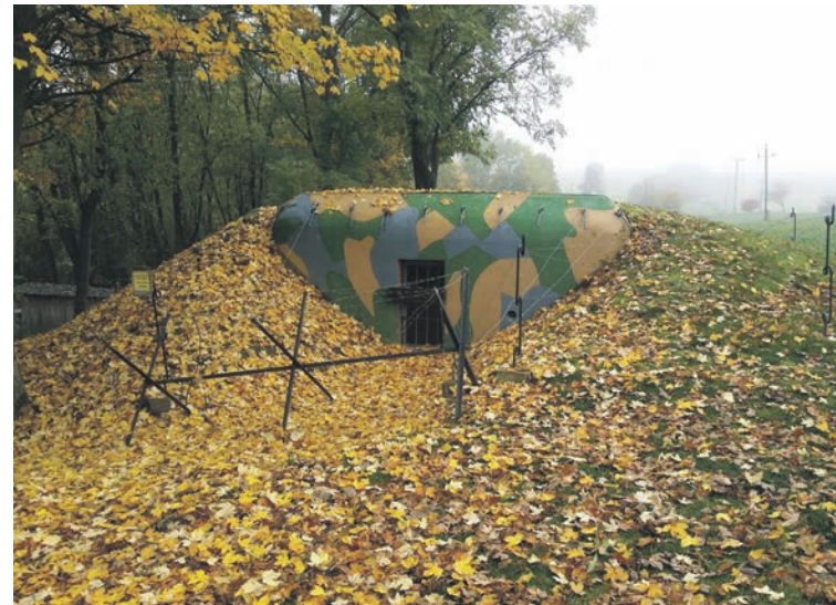
Obnova kamufláže – barevného maskování vojenských bunkrů a pevností vychází z dochovaných původních částí a přizpůsobení okolním přírodním podmínkám, jako třeba u objektů Pevnostního muzea Vranov ve Vranově nad Dyjí.
