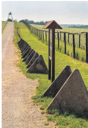
Památník železných opon v Čížově představuje poslední část původních pohraničních zátarasů, včetně strážní věže zvané Špačkárna.
